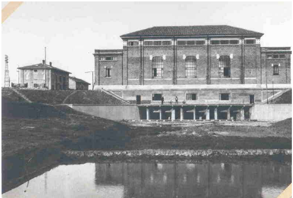
STABILIMENTO IDROVORO VALLE SANTA, FRONTE DELL'ARRIVO, GIUGNO 1925 (ARCHIVIO BONIFICA RENANA).
